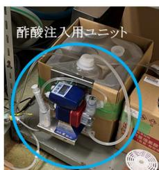
次亜はセントラル装置の薬液ラインに酢酸はセントラル装置のサンプルポートに接続
